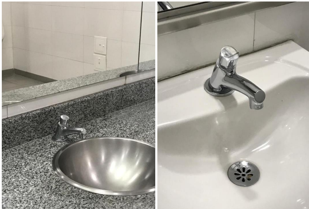
Imagen 7,8. Grifos lavamanos baños de hombres, mujeres y baño de personas en condición de discapacidad edificio central Aeronáutica Civil
