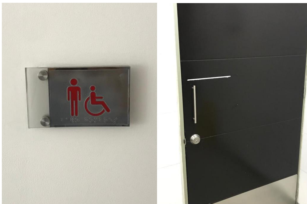
Imagen 3,4. Puerta de acceso al baño de personas en condición de discapacidad edificio central Aeronáutica Civil
